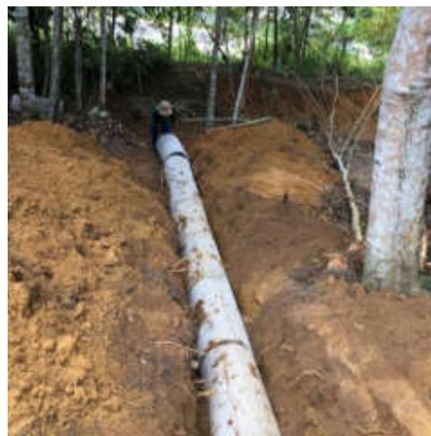
**Fig. 8. Processo de assentamento dos tubos.** Fonte: Os Autores, 2020.
