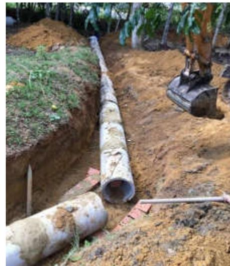
Fig. 5. Local do assentamento dos tubos após a limpeza antes do retrabalho Fonte: Os Autores, 2020.
